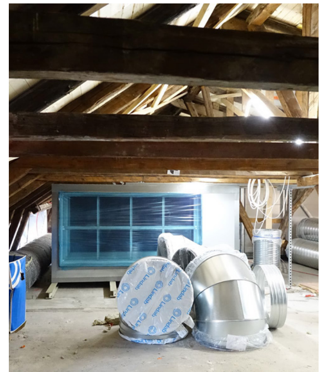
◀ Kallion ala-asteen ullakolle sovitettu paloeristetty ilmastointikone
